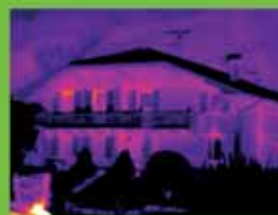
Termografia di una casa CORRETTAMENTE ISOLATA
