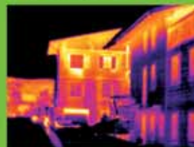
Termografia di una casa NON ISOLATA
